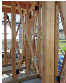
DIT制振筋かい金物の設置状況
