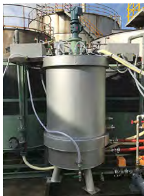
パイロットスケールの連続回分処理装置(処理能力:1m³/日)
