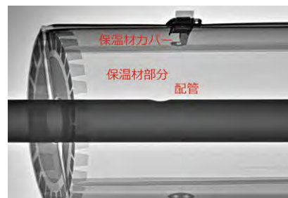
保温材配管のX線画像
