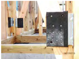
DIT制振筋かい金物
